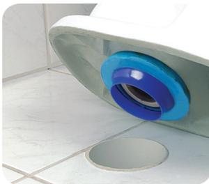
**5-** Certifique-se que o anel esteja bem acondicionado e fixo ao vaso. Utilizando a guia do anel, centralize a saída do vaso a entrada do esgoto e encaixe-o.
