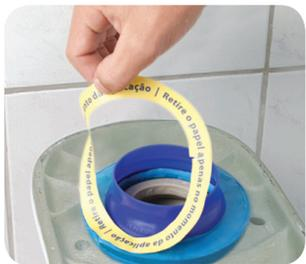
**4-** Coloque o anel na saída do vaso, pressione-o e retire o restante da proteção.
