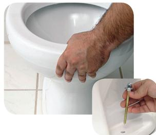
**6-** Pressione o vaso contra o piso para que o anel se acomode e faça a vedação. Em seguida, prenda o vaso com o parafuso de fixação.
