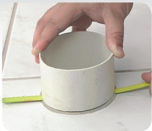
**1-** Retire com uma serra, a sobra do tubo de PVC.
